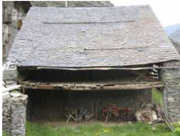
Construcció pel centre
